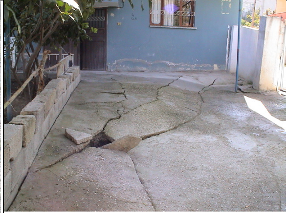
Şekil 2A.4- Bölgede kırıkların oluşturduğu yapısal hasardan görüntüler.
